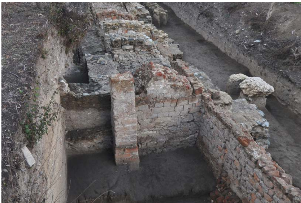
Slika 4. Zidovi 14 i 16, snimak sa jugoistoka.
