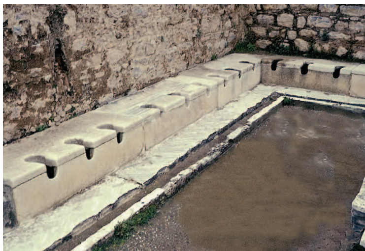
Сл. 13. Римски тоалет у Ефесу, пример камених плоча са уклесаним каналом (према: Magness 2012.) Fig. 13. Roman latrine at Ephesus, an example of stone slabs with an incised channel (after: Magness 2012.)
