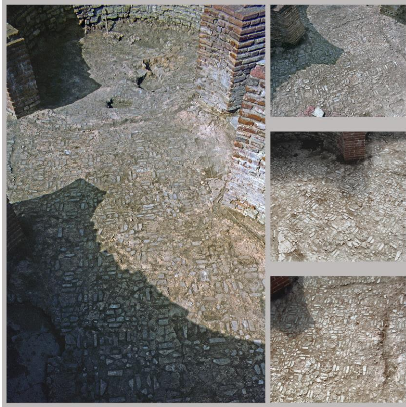
Слика 59 – Субструкција пода у стибедијуму за мермерне плочице (opus sectile)
