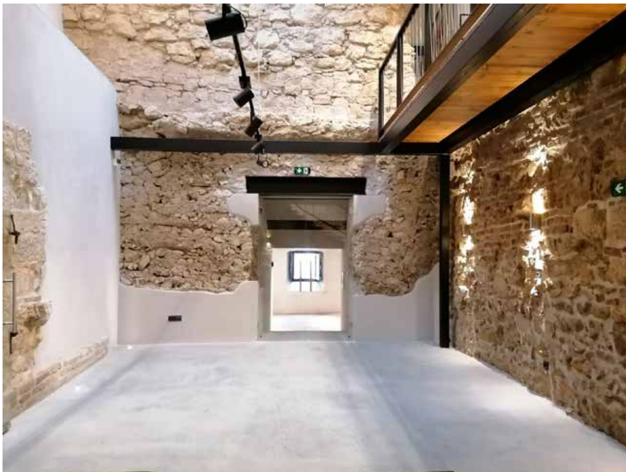
Slika 8a – Zapadna prostorija Sahat kapije nakon završenih radova: pogled sa severozapada. (foto: Dokumentacija KOTO a.d.).
