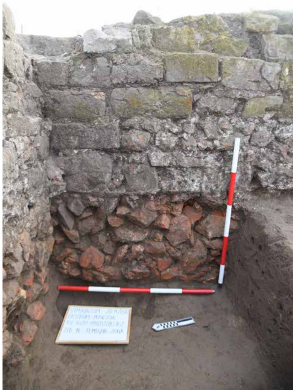
Slika 5 – Izgled zida od crvenke sa temeljnom zonom.
