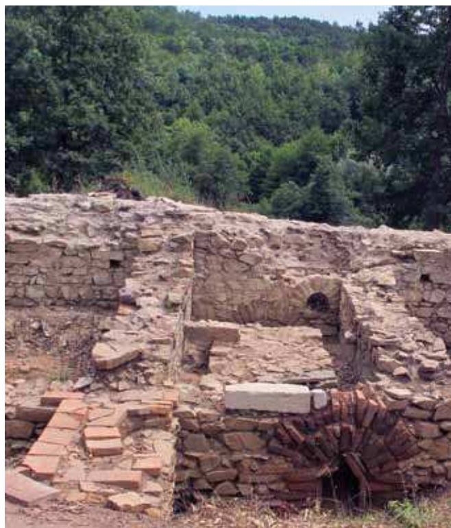
Slika 2 – Prostorija 2, vodotoranj utvrđenja - castellum aquae divisorum (sonda 1/15), sa dovodnim i odvodnim kanalom na južnom bedemu, kamenom platformom – taložnikom, kanalom duž istočnog, zapadnog i severnog zida, kamenim nosačima kontrolnog mosta, pragom ulaza od krečnjačkog bloka, popločanjem od opeka i polukružnom nišom na istočnom zidu starije fortifikacije i kanalom od opeka za dovod vode u utvrđenje na južnom zidu starije fortifikacije, sa severa (S. Petković)
