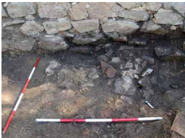
Slika 2b – Urušena malterna podnica iznad devastiranog hipokausta sa zapečenom zemljom u osnovi u severoistočnom delu kule 2, snimak sa jugozapada
