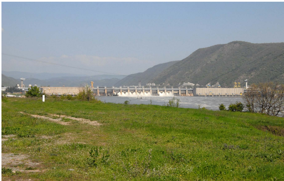
75. Hydroelectric power plant Đerdap I, near Kladovo 75. Hidroelektrana Đerdap I kod Kladova
