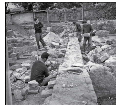
Сл. 6 - Конзервација терми, детаљ
