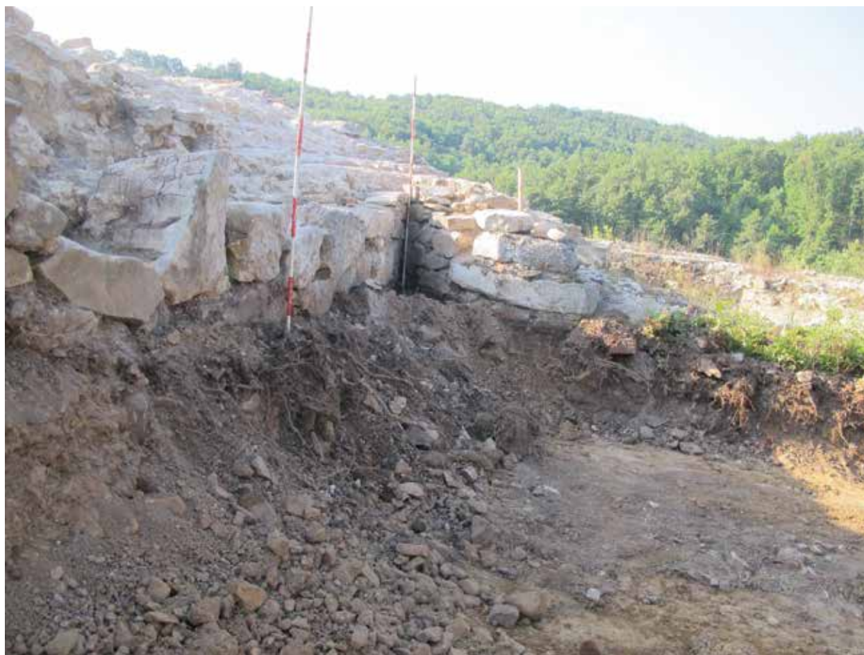
Slika 3. Spoljašnje lice zapanog bedema između zapadne kapije i kule 1, sa severozapada.
