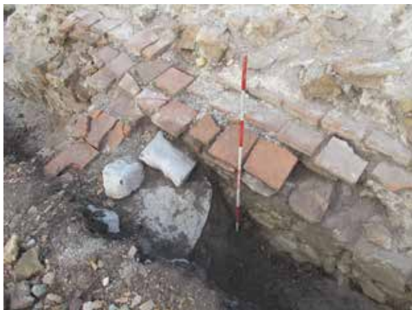
Slika 7. Zid upravan na unutrašnje lice zapadnog bedema južno od zapadne kapije (severni zid prostorije 4), sa severoistoka.
