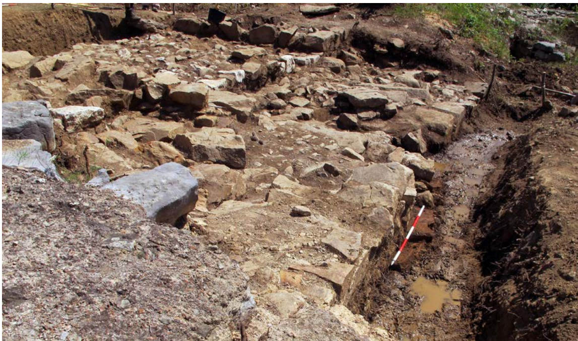
Slika 7. Ostaci drenažnog kanala uz spoljašnju stranu temeljne zone zapadne kapije, sa severozapada (foto S. Petković).
