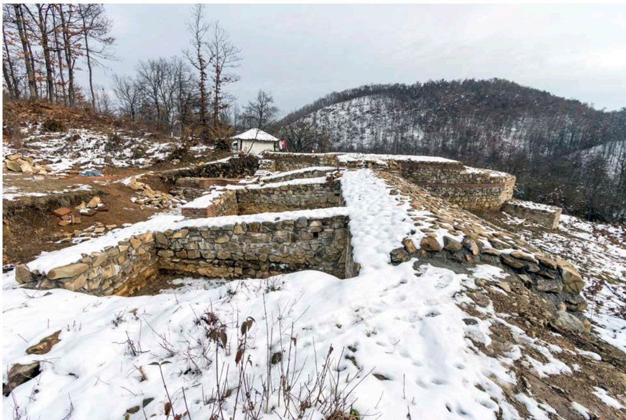
Slika 1. Jugoistočni ugao utvrđenja carske rezidencije na Šarkamenu sa izvedenim konzervatorsko-restauratorskim radovima, sa zapada (foto G. Janjić).
