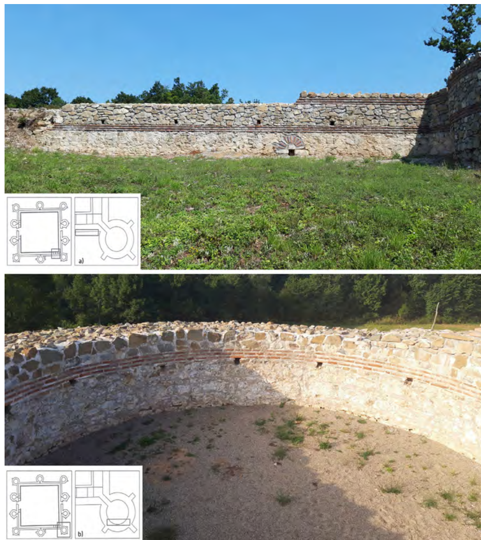
Сл. 7. Положај дрвених сантрача на кулама (а) и бедемима (б) унутар система шаркаменске фортификације
