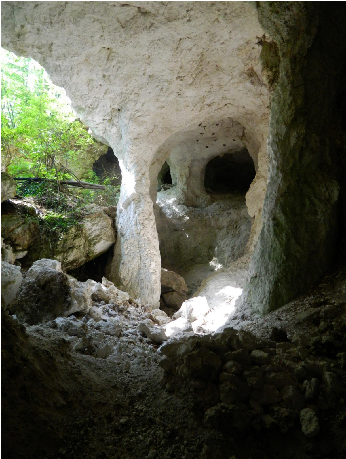
Slika 52. Visoka galerija unutar rudarskog okna sa obrušenim stenskim materijalom (foto: autor).
