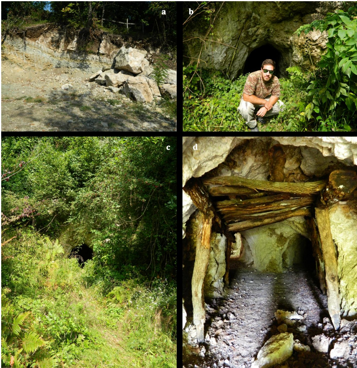
Slika 51. Rudnik magnezita u selu Lazac, ulaz u okno rudnika i drvene podgrade koje drže tavanicu ulaza u okno ( foto: Blagoje Dimić i autor ).
