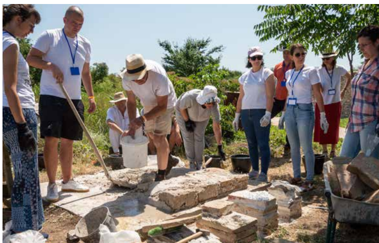
Slika 2. Izrada tradicionalnih krečnih maltera i zidanje kamenom i opekam za potrebe buduće konzervacije tokom radionice održane u Viminacijumu 2022. godine u okviru projekta MoDeCo2000 (foto: Goran Stojić)
