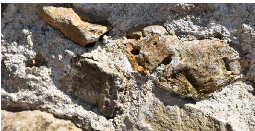
Slika 119. Primena konzervatorskih mešavina maltera na danas oštećenim istorijskim strukturama, pre više decenija delimično restauriranim cementnim malterom: zidanje u junu (gore); nakon 18 dana, jul (sredina); nakon 398 dana, jul (dole); primetna je razlika u boji novog maltera i davno primenjenog cementnog maltera
