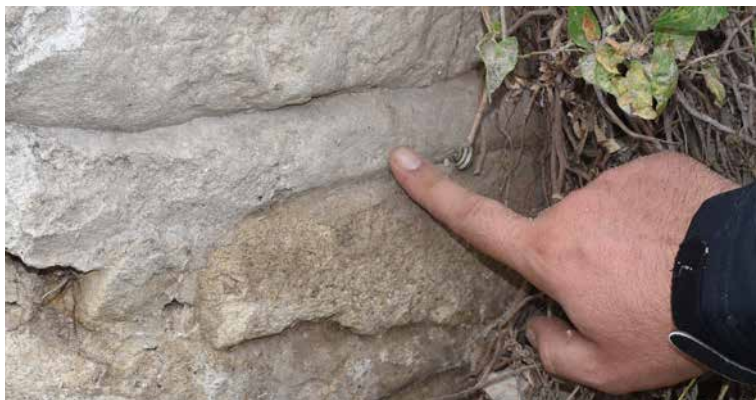
Slika 10. Rimski malteri dunavskog limesa u Srbiji za ispunjavanje spojnica – fugovanje: Kastrum Oktavum
