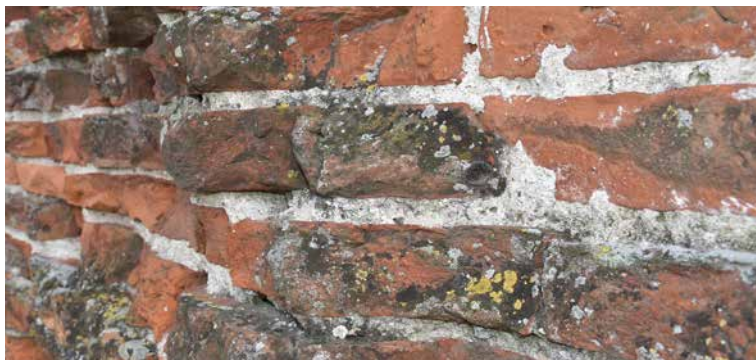
Slika 109. Biološki rast na istorijskoj zidanoj strukturi dunavskog limesa – lišajevi i mahovine Trajanovog mosta
