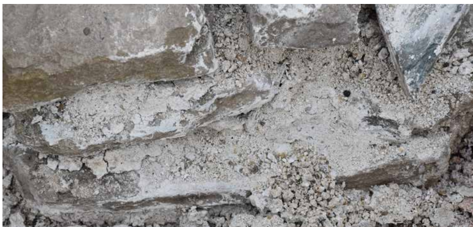
Slika 108. Primer pogubnog uticaja mraza na nezaštićen krečni malter sa vazдушnim krečom koji još nije prošao kroz karbonatizaciju
