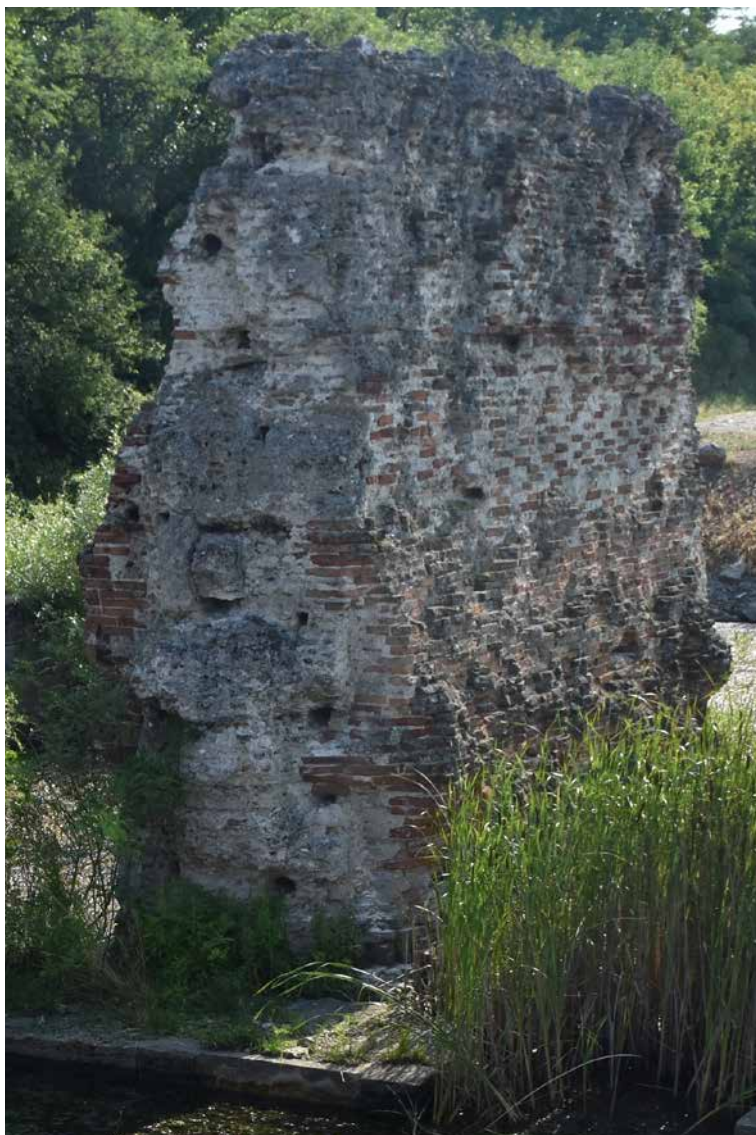
Slika 16. Trajanov most na Dunavu: očuvani stubac na srpskoj obali, najbliži reci, na kome se vide ostaci lica od opeka i kamena i jezgro
