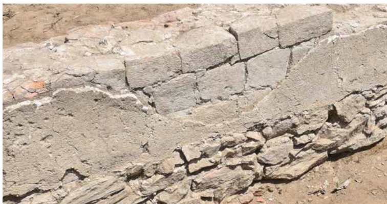
Slika 12. Rimski malteri dunavskog limesa u Srbiji za spoljašnje materisanje (gore) i unutrašnje malterisanje (dole): Viminacijum
