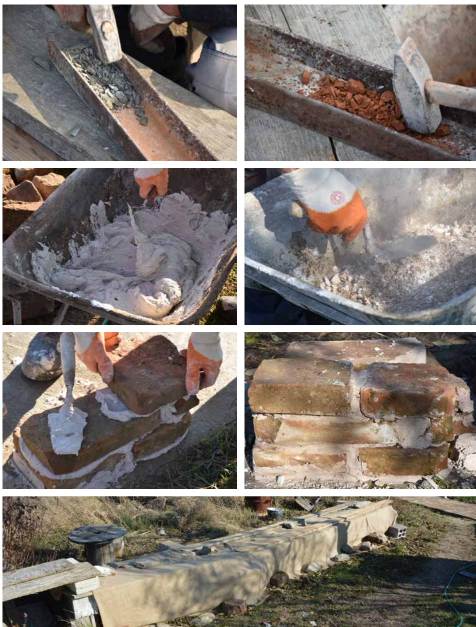
Slika 116. Izrada i primena konzervatorskih mešavina maltera na zidanim strukturama u Viminacijumu (oktobar)
