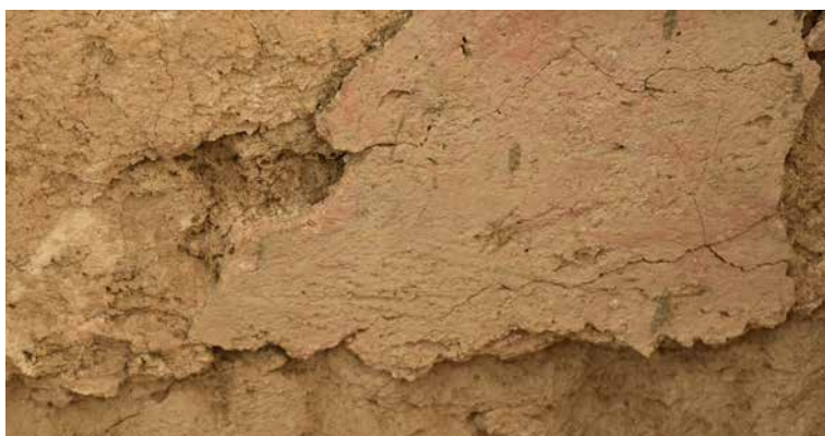
Slika 11. Rimski malteri dunavskog limesa u Srbiji za podove (slojevi iz više faza građevine): Viminacijum
