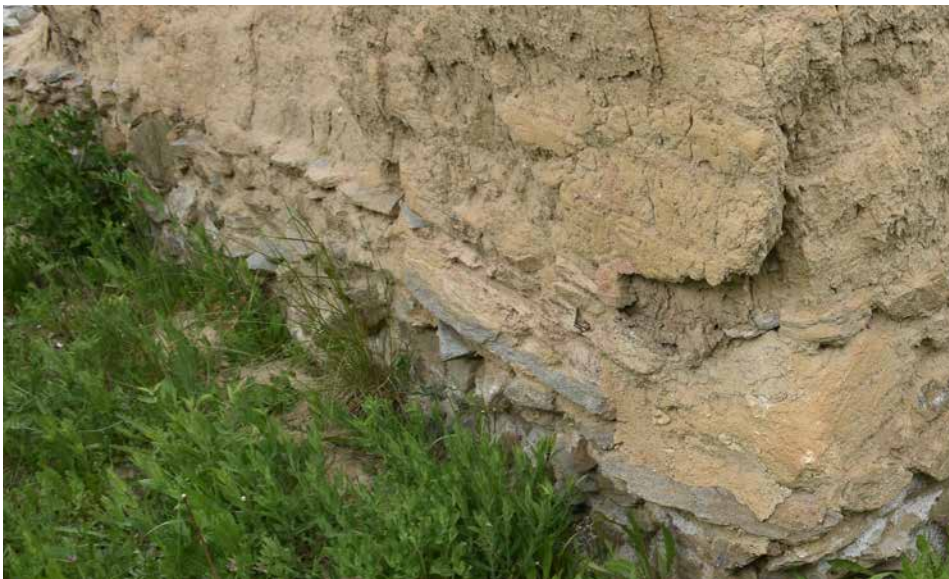
Slika 78. Blatni malteri antičkih građevina na dunavskom limesu u Srbiji
