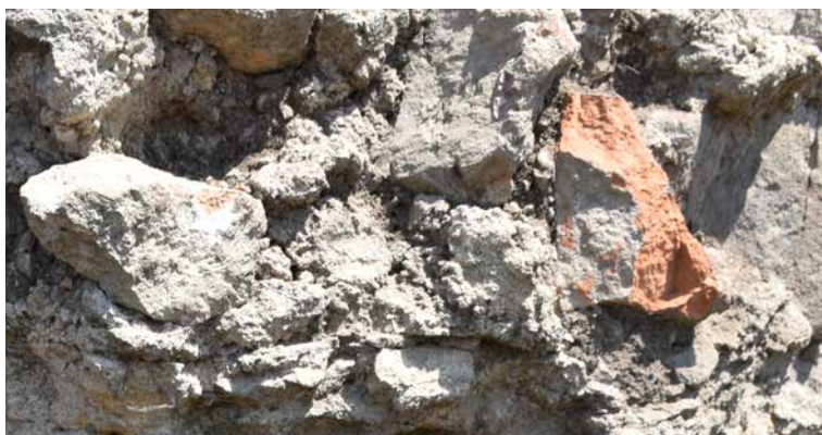
Slika 9. Rimski malteri dunavskog limesa u Srbiji u jezgrima zidova: Kastrum Nove (gore), Viminacijum (dole)
