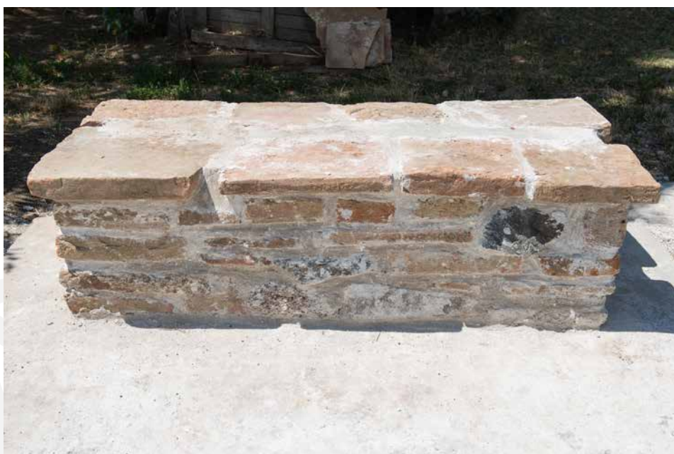
Slika 121. Građenje zidane strukture na radionici u Viminacijumu (gore – foto: Goran Stojić); zidana struktura 13 dana nakon nastanka (dole)
