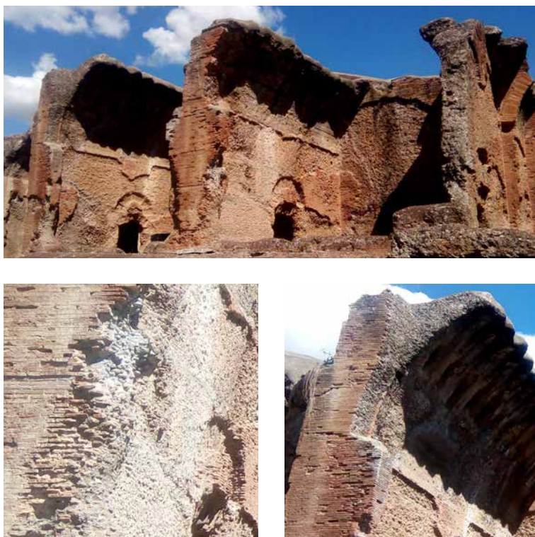
Slika 14. Hadrijanova vila u Tivoliju, Italija – vidljiva jezgra od rimskog betona sa licima od opeke (privatna arhiva: Emilija Nikolić)
