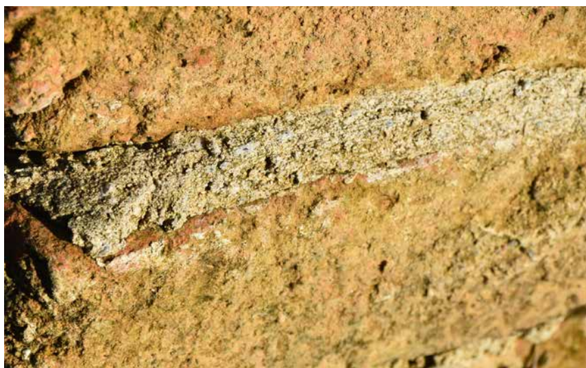
Slika 117c. Monitoring primenjenih mešavina maltera na zidanim strukturama u Viminacijumu: Struktura 4 – nakon 587 dana, januar (očvrslu malter za zidanje bez oštećenja)
