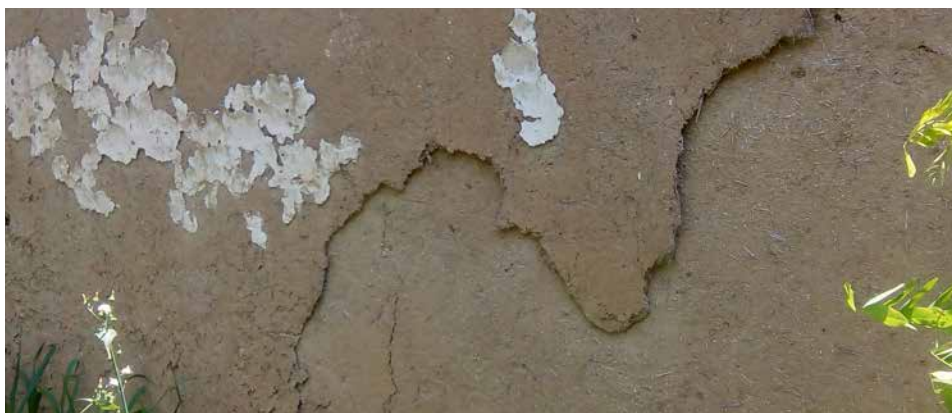
Slika 79. Blatni malteri kuće u jednom od današnjih sela na dunavskom limesu, koji su opstali skoro jedan i po vek, ali usled napuštanja kuće i posledičnih oštećenja, nestaju zajedno sa njom (privatna arhiva: Emilija Nikolić).
