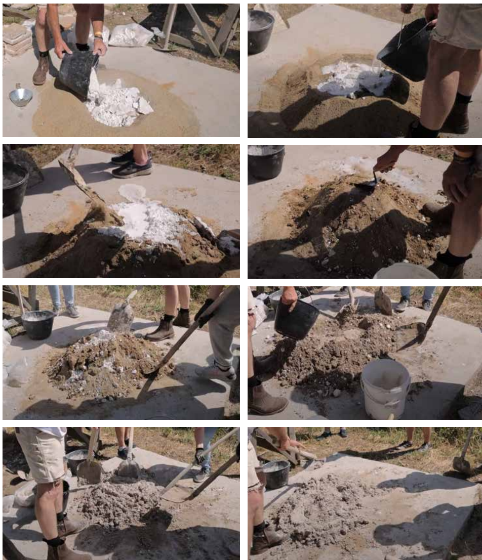
Slika 96. Izrada maltera sa živim krečom tokom radionice projekta MoDeCo2000 u Viminacijumu (fotografije nastale iz video-materijala koji je snimio Dragan Beljić)
