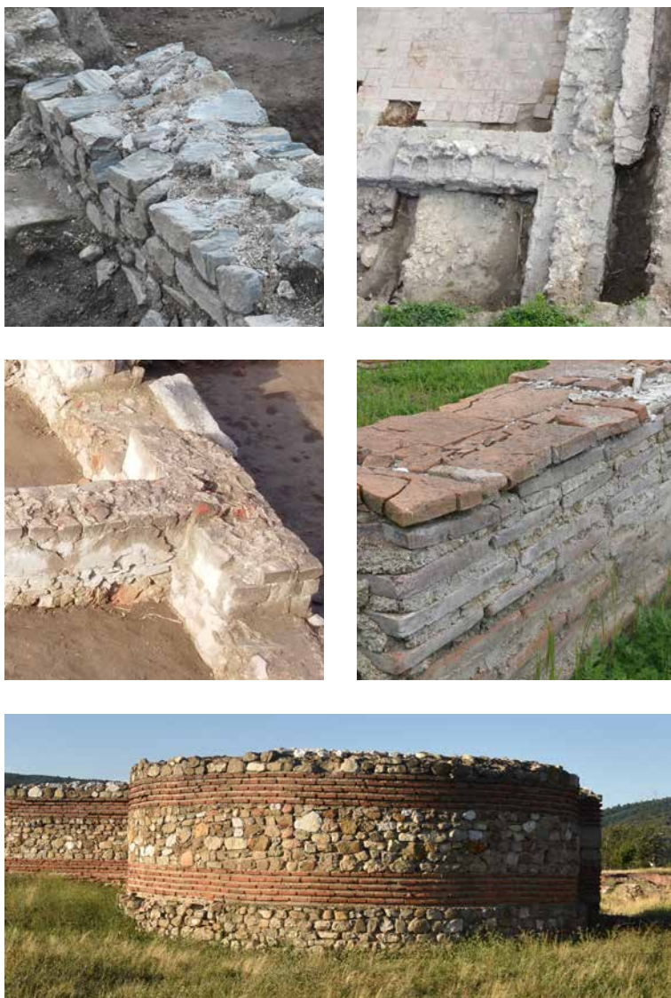
Slika 15. Zidovi građevina dunavskog limesa u Srbiji: lice u tehnici sličnoj opus incertum i ispuna zida (trpanac) od lomljenog kamena (Viminacijum, gore levo – stanje tokom iskopavanja); otisci u malteru nakon vađenja kamena sa vidljivom ispunom (Viminacijum, gore desno – stanje tokom iskopavanja; Arhiva Arheološkog instituta, foto: Nemanja Mrđić); zid od blokova crvenke sa ispunom u vidu trpanca (Viminacijum, sredina levo – stanje tokom iskopavanja; Arhiva Arheološkog instituta, foto: Nemanja Mrđić); zid od opeka bez ispune (Viminacijum, sredina desno – stanje tokom iskopavanja); lice bedema i zidova kula utvrđena izvedeno u tehnici opus incertum mixtum bliskoj opus vittatum mixtum (Dijana, dole – restaurirani zidovi).
