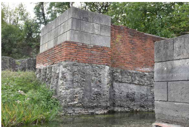
Slika 17. Trajanov most na Dunavu: jezgro u vrhu najočuvanijeg stupca kome nedostaju lica (gore); restaurirani stubac s vidljivim otiscima oplata u temelju (dole)
