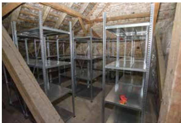
Slika 2. Montaža polica (2018. godina).
