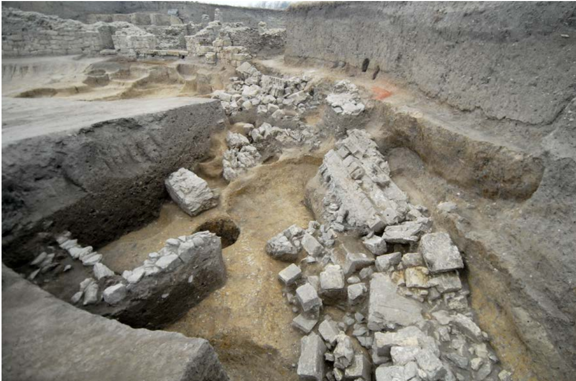
Sl. 181. Obrušeni deo zida arene u severozapadnom delu amfiteatra, pogled sa istoka (dokumentacija Arheološkog instituta Beograd)
