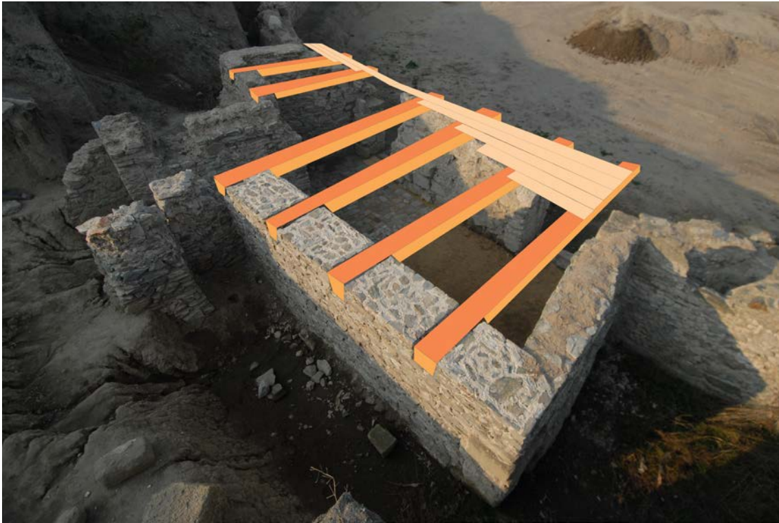
Sl. 271. Prikaz drvene konstrukcije iznad prostorija u južnom delu viminacijumskog amfiteatra
