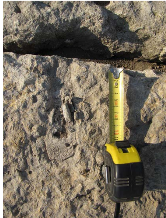
Sl. 290. Spoljašnji zid amfiteatra: a) ležišta za spojnice; b) udubljenja za pomeranje blokova (foto: I. Bogdanović)
