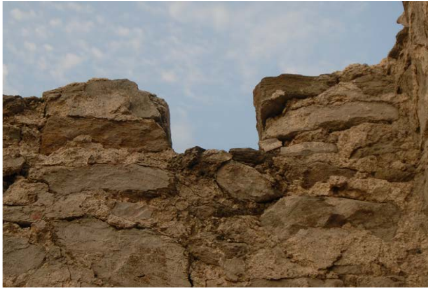
Sl. 193. Ležište za drvenu gredu u okviru zida 11 (foto: I. Bogdanović)
