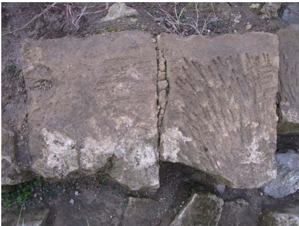
Sl. 337. Tragovi obrade na blokovima krečnjaka, koji su činili zid arene (foto: I. Bogdanović)
