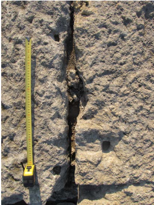
Sl. 290. Spoljašnji zid amfiteatra: a) ležišta za spojnice; b) udubljenja za pomeranje blokova (foto: I. Bogdanović)
