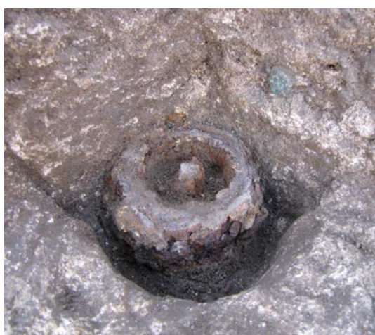
Sl. 210. Donji deo osovine za vrata, Zapadni ulaz: a) osovina in situ ; b) osovina (foto: Lj. Jevtović i I. Bogdanović)
