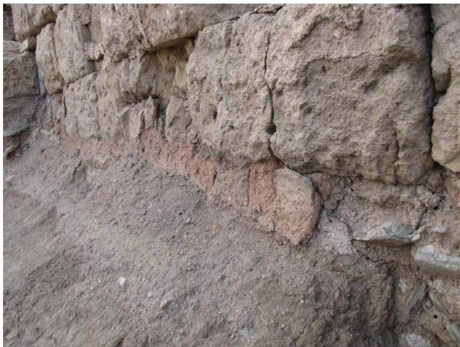
Sl. 198. Obloga donje zone zida arene, koja je izvedena od hidrostatičkog maltera (dokumentacija Arheološkog instituta Beograd)
