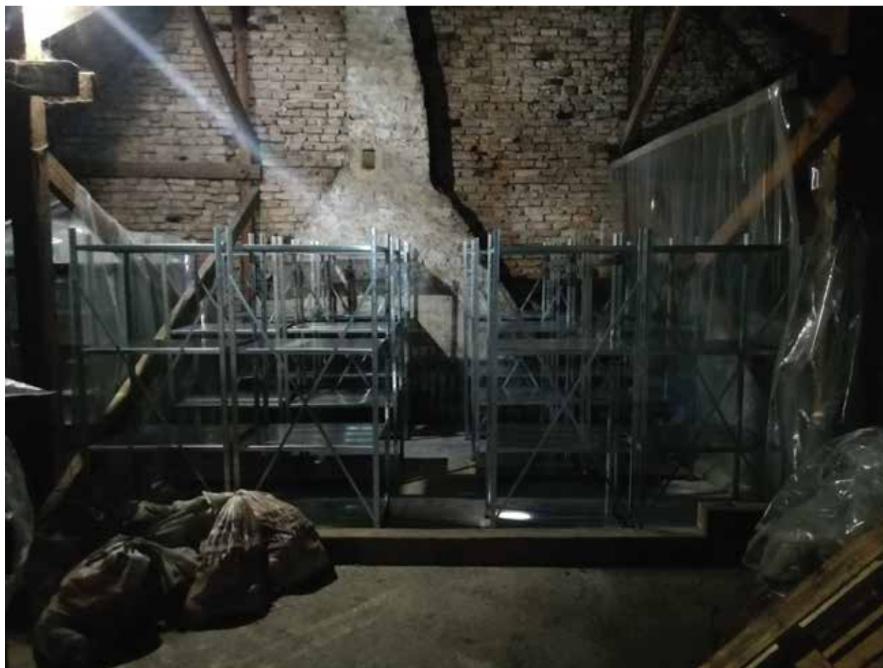
Slika 5. Montaža polica (2019. godina).
