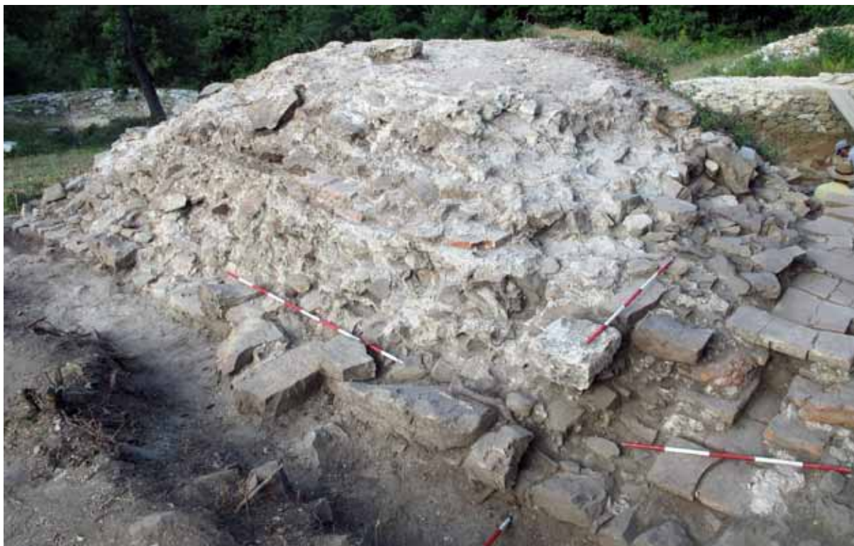
Slika 6 – Koridor ulaza u kulu 2, snimak sa severoistoka
