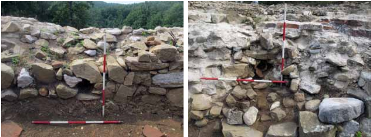
Slika 4 – Otvor kanala sa keramičkom cevi na unutrašnjem (a) i spoljnom (b) licu južnog dela zida kule 2
