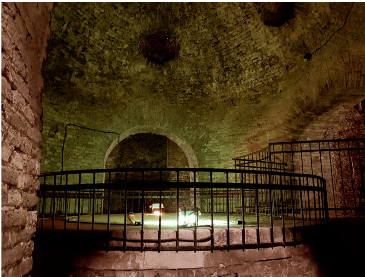
Сл. 56. Велики бунар у Београдској тврђави – радна платформа над сувим окном у заштитној улазној грађевини (ЈП „Београдска тврђава”)
