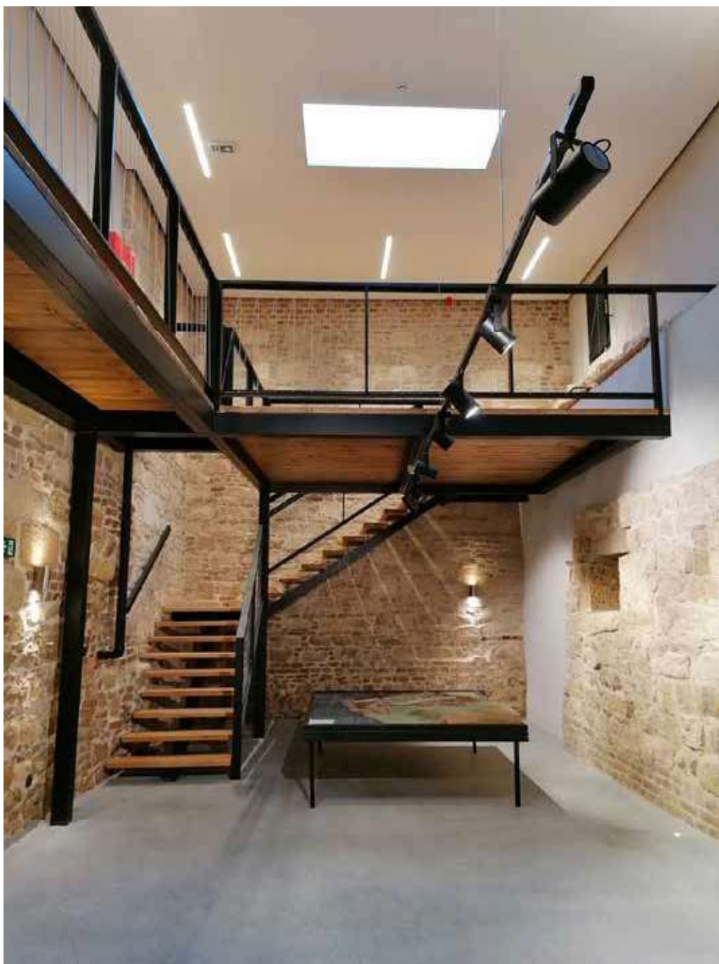
Slika 8b – Zapadna prostorija Sahat kapije nakon završenih radova: pogleda sa jugoistoka. (foto: Dokumentacija KOTO a.d.).
