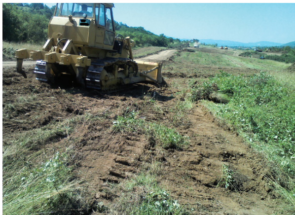
Slika 5 – Lokalitet Čivlak – Polom, uklanjanje površinskog humusa
