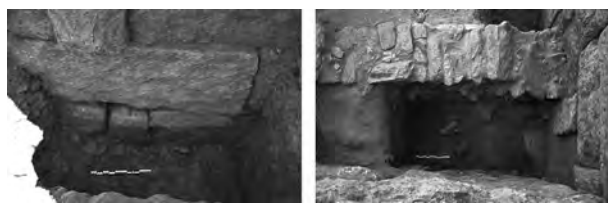
Fig. 6.2.9. : Sondages profonds, fondations du mur sud de la Doric House et du mur ouest des bains (MR 6007) (Chr. Bost).
