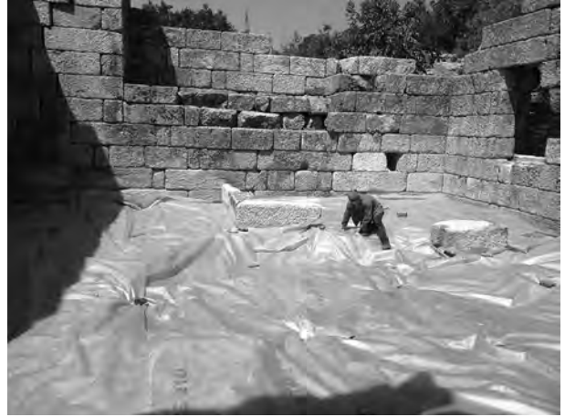
Fig. 3.3.2 : Pose du revêtement géotextile dans l' Andrôn A (O. Henry).
