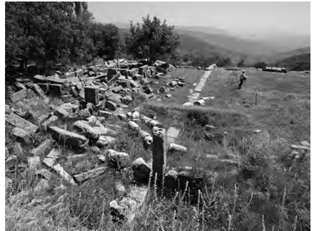
Fig. 5.7.3 : La Stoa Est avant le début des travaux (B. Vergnaud et N. Careless-Unwinn).
