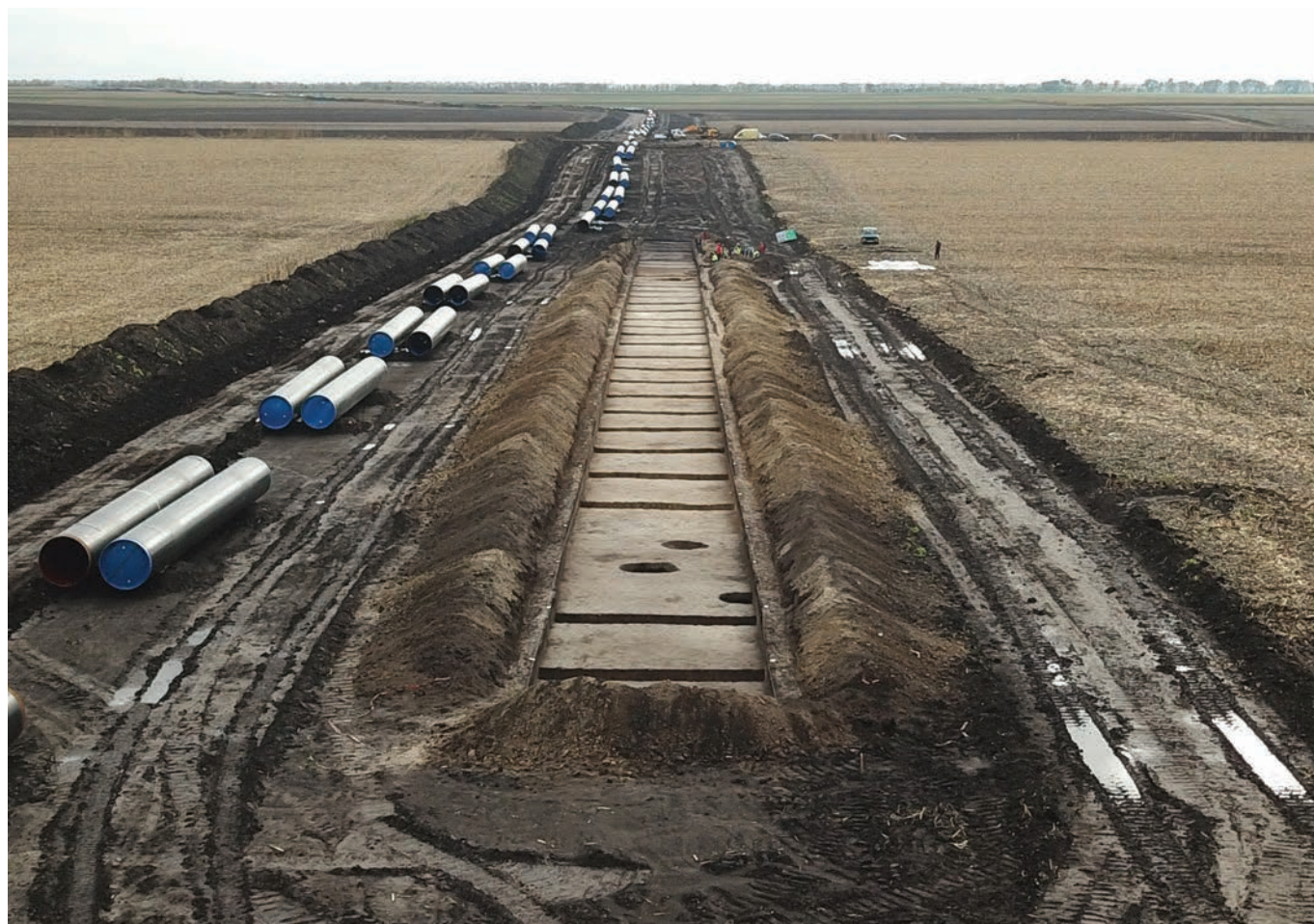
Слика 2. Траса гасовода са позицијом археолошког ископа, фото И. Киш Малиновић и Н. Шарчевић, документација Међуопштинског завода за заштиту споменика културе Суботица Figure 2. Excavation location in respect to the pipeline route, photo by I. Kiš-Malinović and N. Šarčević, Documentation of the Intermunicipal Institute for the Protection of Cultural Monuments Subotica
